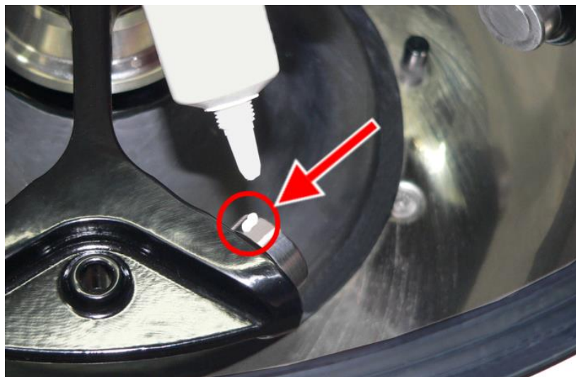
Abb. 37: ausreichende Menge Tragbolzenfett für einen Bolzen
