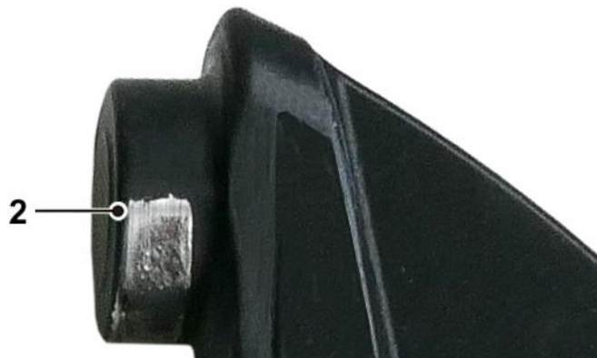
Abb. 7: Tragbolzen mit komplett abgenutzter Gleitbeschichtung – Fetten ist notwendig
